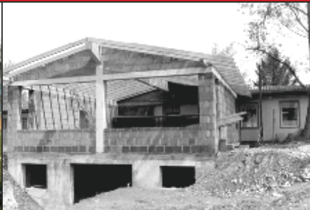
Bild 129: 1990, Der dritte Anbau des Clubheims im Rohbauzustand. Bild: RZ/FCK
