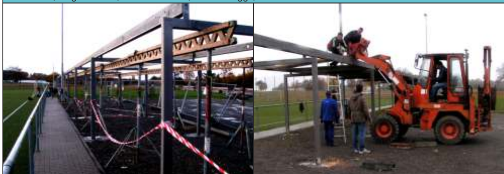
Bild 842 u. 847: 2009, Der (verstärkte) "Bautrupps" des FCK bei der Montage der Überdachung am Kunstrasenplatz, Bilder: KHS/FCK
